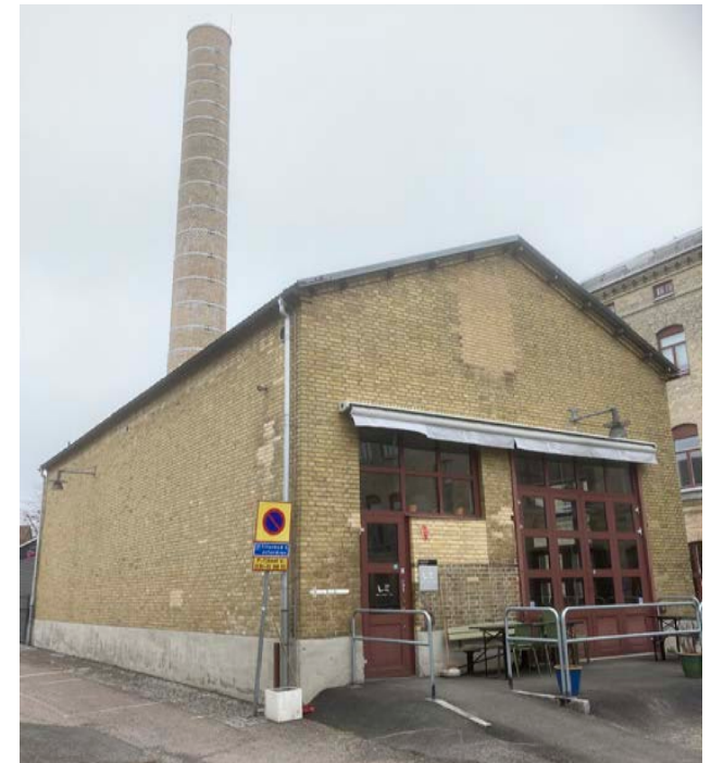
Fasad mot söder. Byggnadens nyttofunktion märks i avsaknad av estetisk fasadordning. Verkstadsliknande byggnadsgrupp ihop med skorstenen.
