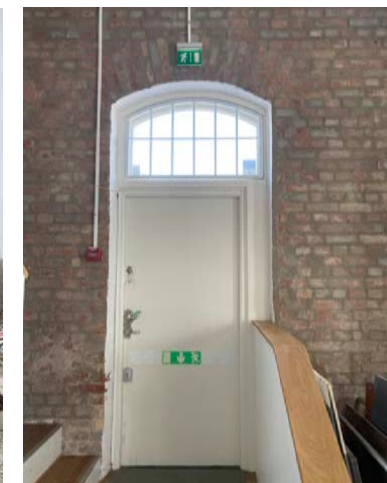
Den ena dörren mot öster med bevarat överluftsfönster.
