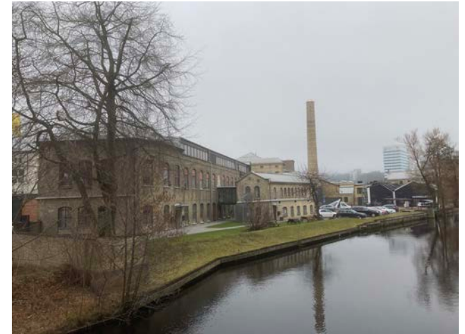
Bron över Mölndalsån på Skårs led är både idag och historiskt fabriksområdets huvudentré varifrån industrikaraktären som helhet särskilt väl kan upplevas.
