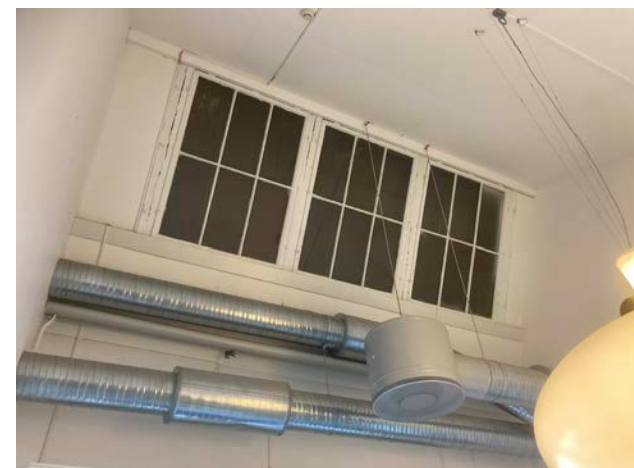
I sågtandstakets nordligaste sektion finns ursprungsfönster bevarade, igensatta enbart utifrån.
