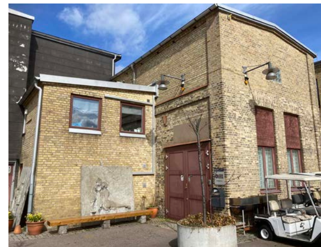
Den yngre tillbyggda delen mot söder med mer oregelbunden fasadrytm och planform, samt flackt sadeltak.
