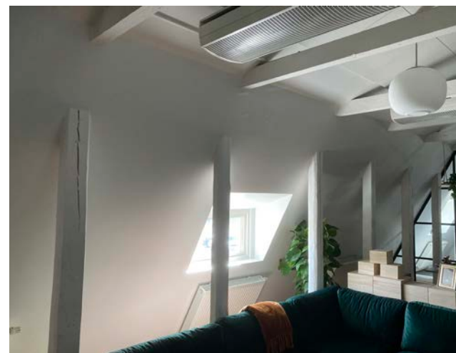
Ovanvåningen med synlig takstolskonstruktion.
