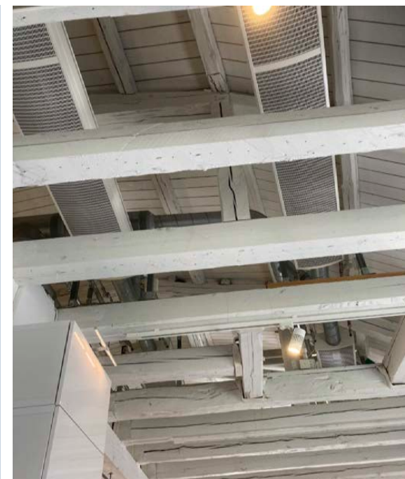
Takstolskonstruktion med hanband och stödben och högben bär upp det rundade taket.
