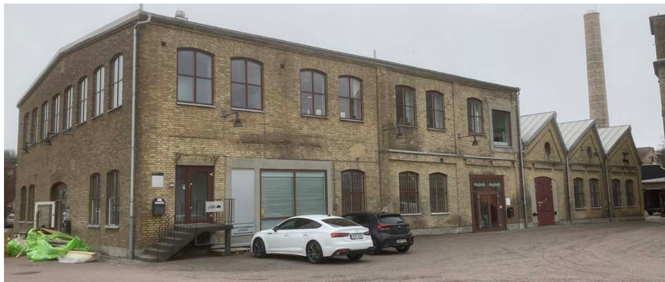
Appreturbyggnaden sett från öster med den södra utbyggnaden närmast i bild. Murverket ändrar på ett tydligt sätt karaktär vilket visar på den successiva utbyggnaden.
