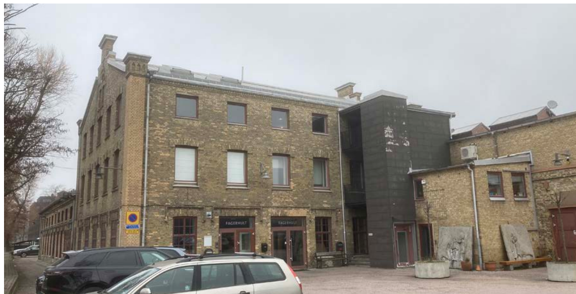
Färgeriet sett från söder. Byggnaden bär prägel av de successiva utbyggnaderna under årens lopp.
