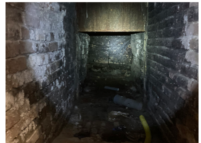
Murverk och järnkonstruktion från den äldsta brännkammaren finns kvar i dagens byggnad.
