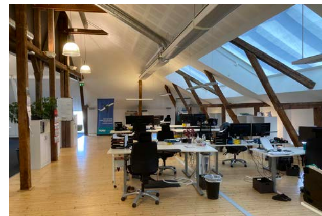
Vindsplanet med bevarad synlig takstolskonstruktion och bärande pelare.
