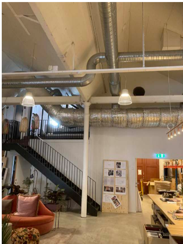
Industrihallen med slipat betonggolv, gjutjärnskolonner och balkar samt sågtandstak.
