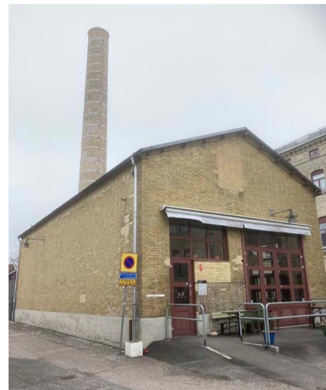
Pannhus med skorsten
